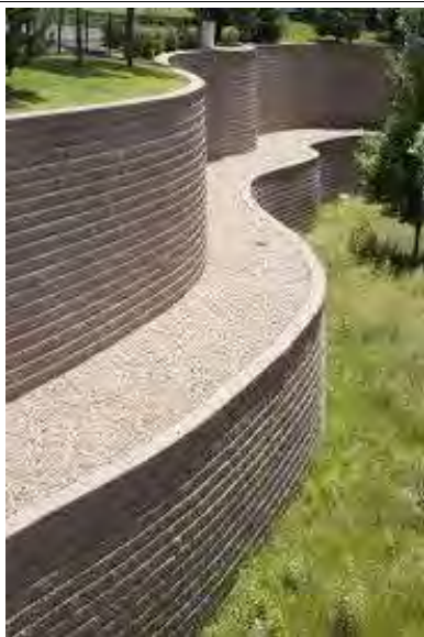
Structure en briques Béton © Allied
