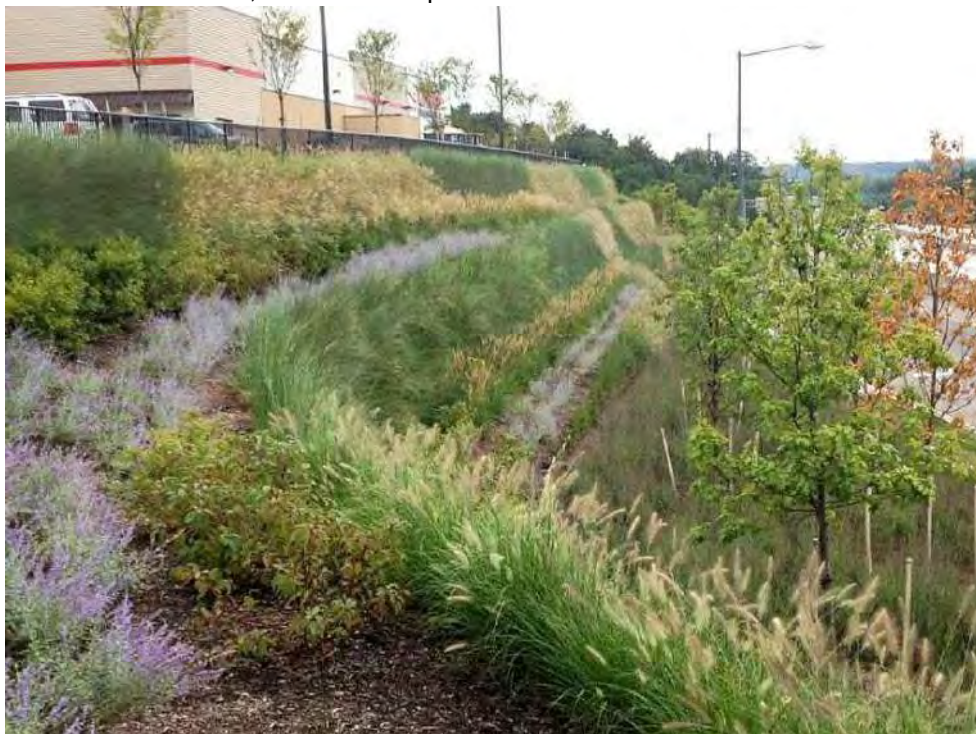
Mur de soutènement végétalisé sur talus, Dakota. Furbish 2013.
