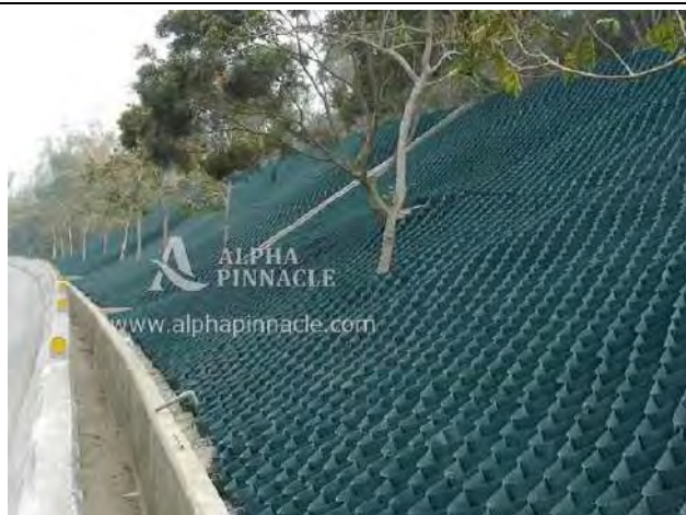
Un talus couvert de géocellules © Alpha Pinnacle
