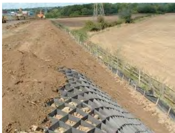
Un talus couvert de géocellules et rempli de terre arable © Terram geosynthetics
