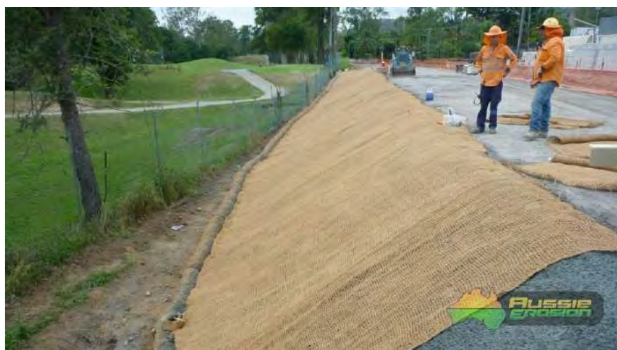
Placement d'un filet de fibre de coco
