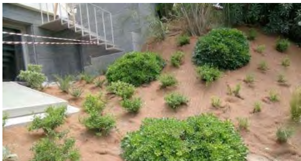
Filet de fibre naturelle avec revégétalisation
