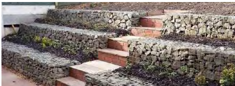
Les gabions sont utilisés comme soutien du sol sur une surface de sol en pente
