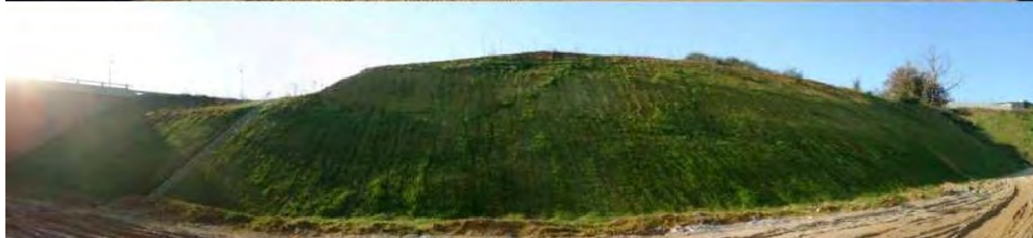
Remblai ensemencé de manière hydraulique sur la voie ferrée à grande vitesse Madrid-Galicia
