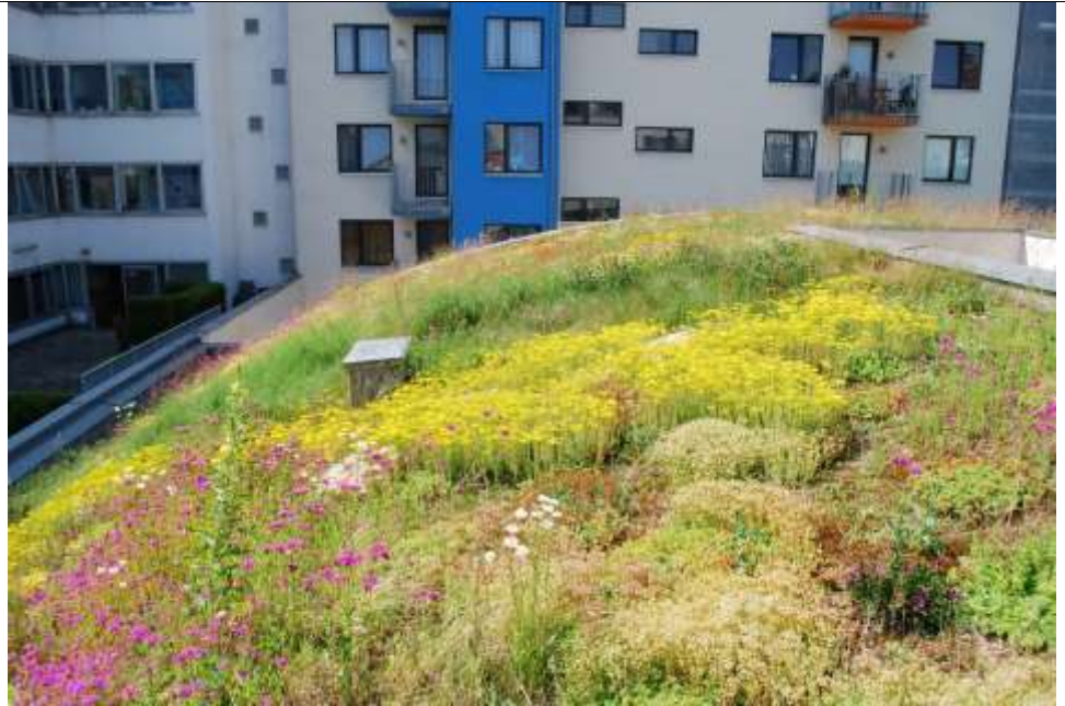
Toit vert extensif sur un bâtiment de bureaux en cours intérieur d'un îlot d'habitat, Autriche © Verband für Bauwerksbegrünung (VfB)
