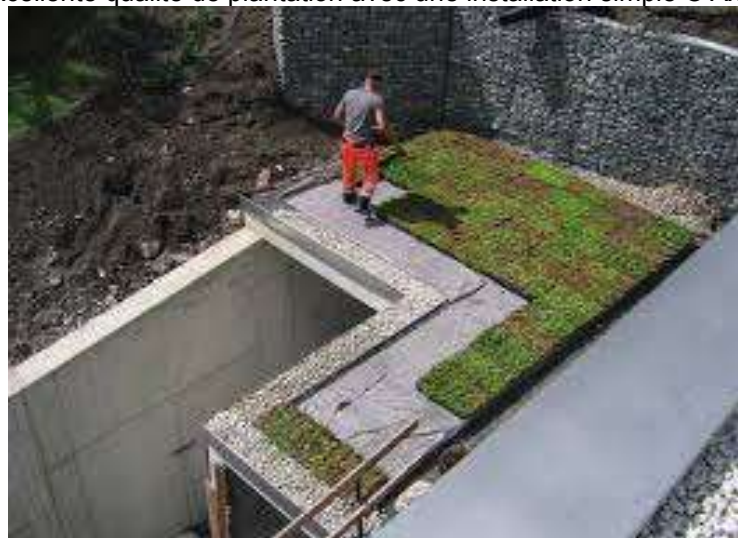
Installation d'un toit vert extensive pré-fabriqués, Autriche © Haas
