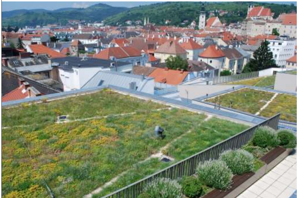
Niederösterreich Haus Krems, Autriche Propriétaire: NÖ Landesimmobiliengesellschaft mbH © Verband für Bauwerksbegrünung VfB
