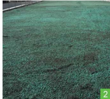
Apparence d'un toit vert obtenu par épandage de boutures de sedum cuttings. 1. Par épandage manuel / 2. Par épandage en gel © Vegetal I.D.
