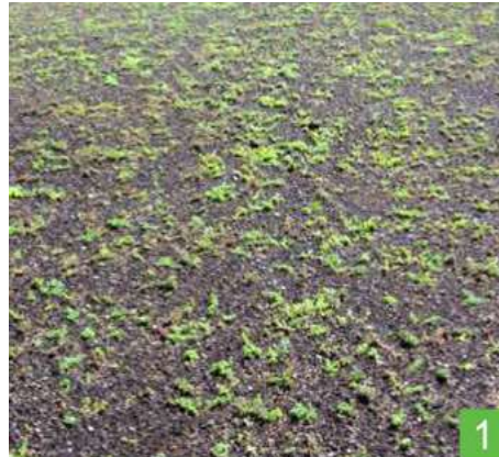
Apparence d'un toit vert obtenu par épandage de boutures de sedum cuttings. 1. Par épandage manuel / 2. Par épandage en gel © Vegetal I.D.
