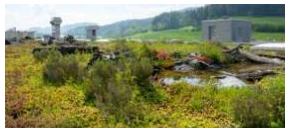
Toit vert extensif incluant des structure support pour les abeilles sauvages et des zones d'eau temporaires © Bauder
