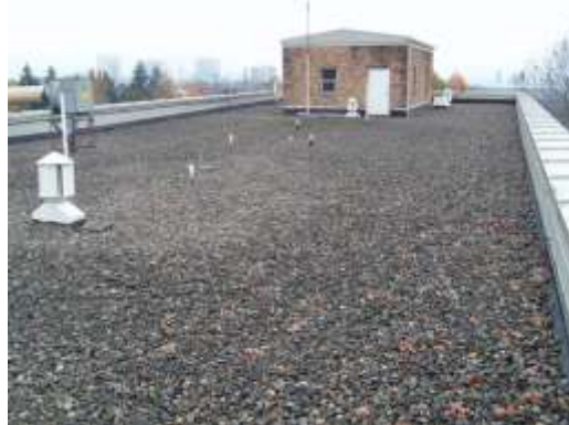
Toit de graviers © Anderson Roofing
