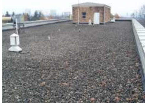
Toit de graviers © Anderson Roofing
