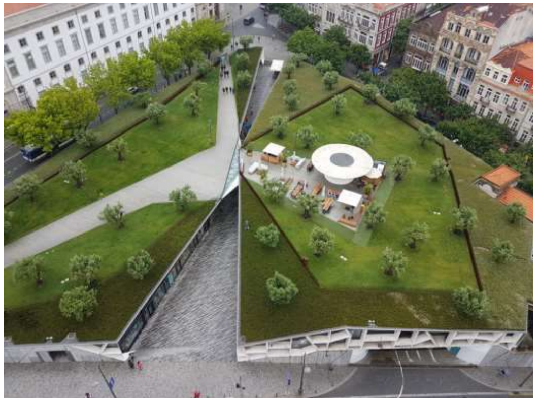
Toiture verte intensif (parc) sur un centre commercial, Porto, Portugal © European Federation of Green Roof Associations (EFB)
