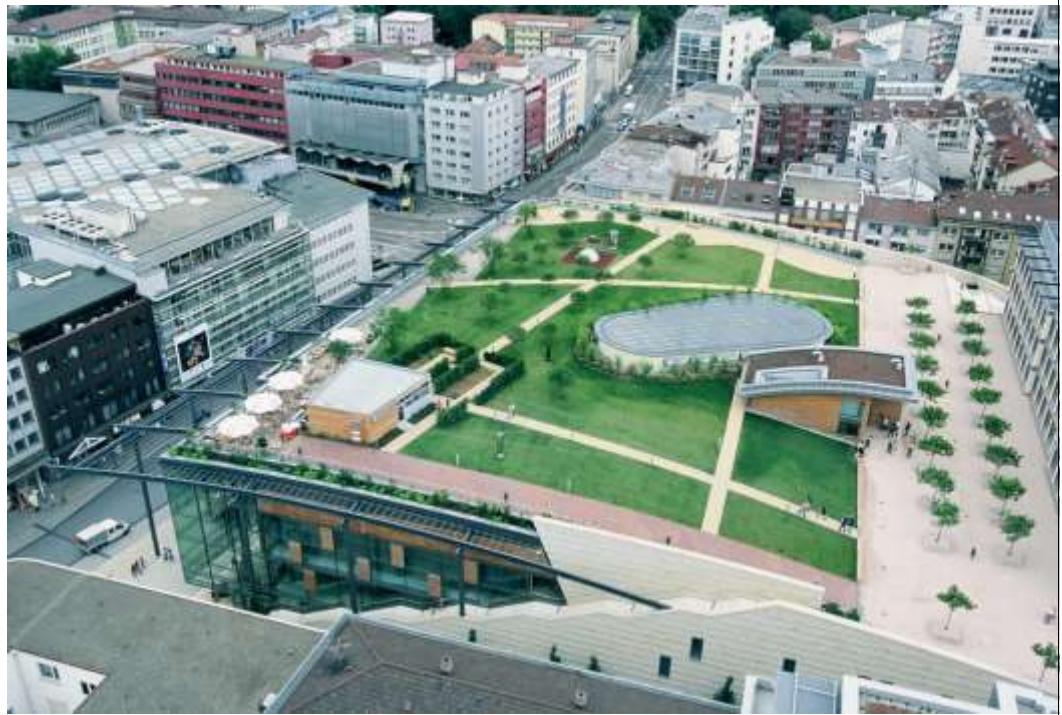
Toit vert intensif sur un centre commercial, Allemagne © European Federation of Green Roof Associations (EFB)
