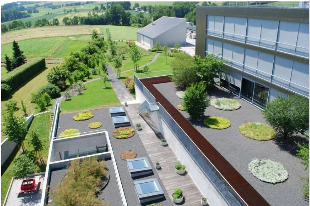
Toit vert intensif partiellement couvert, Autriche @Verband für Bauwerksbegrünung (VfB)
