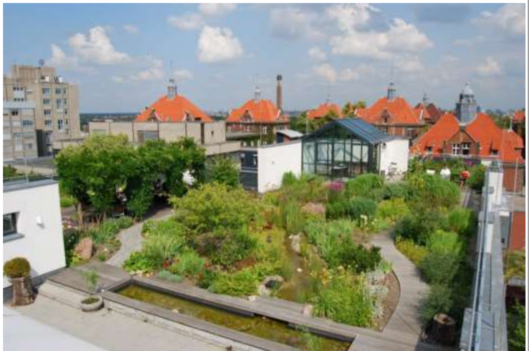
Toit vert intensif d'un hôpital, Allemagne © EFB
