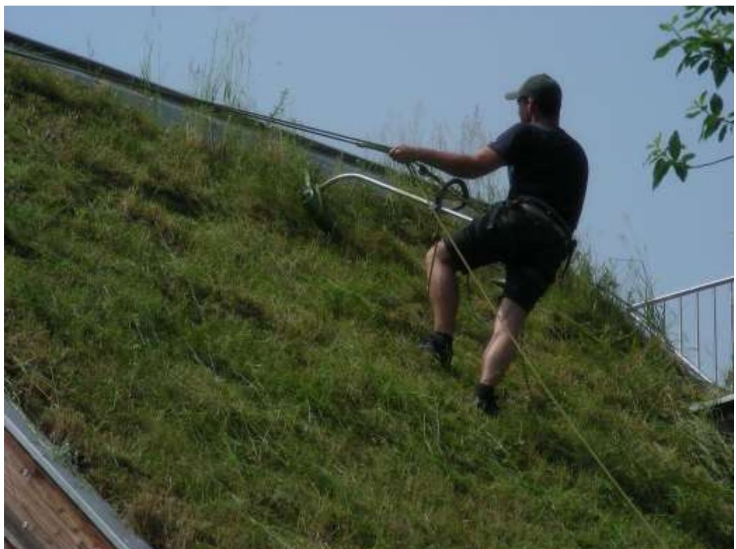
Maintenance d'un toit de pelouse naturelle pour la biodiversit, Timer construction, Autriche © Fricke
