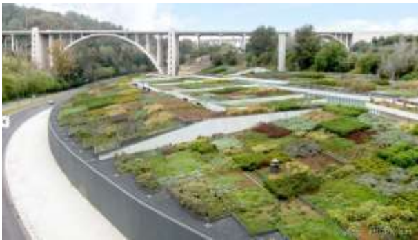
Toit vert extensive à semi-intensif, Lisbonne Portugal © EFB
