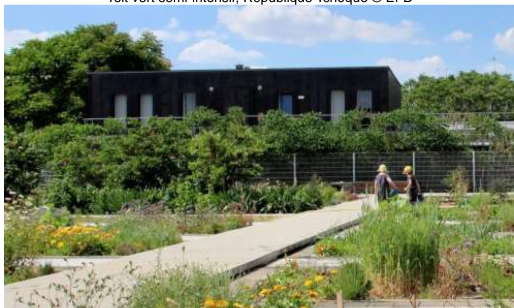
Toit vert semi-intensif partiellement recouvert et jardiné, France © EFB
