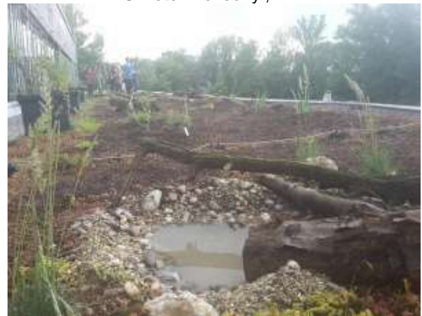
Toit vert semi-intensif pour la biodiversité nouvellement installé à Vienne, Autriche © Fricke, VfB
