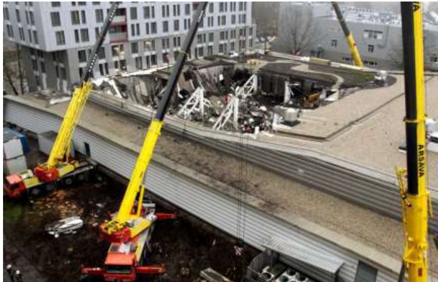
Rénovation d'un centre commercial à Riga, Lettonie, le toit s'est effondré durant l'installation
