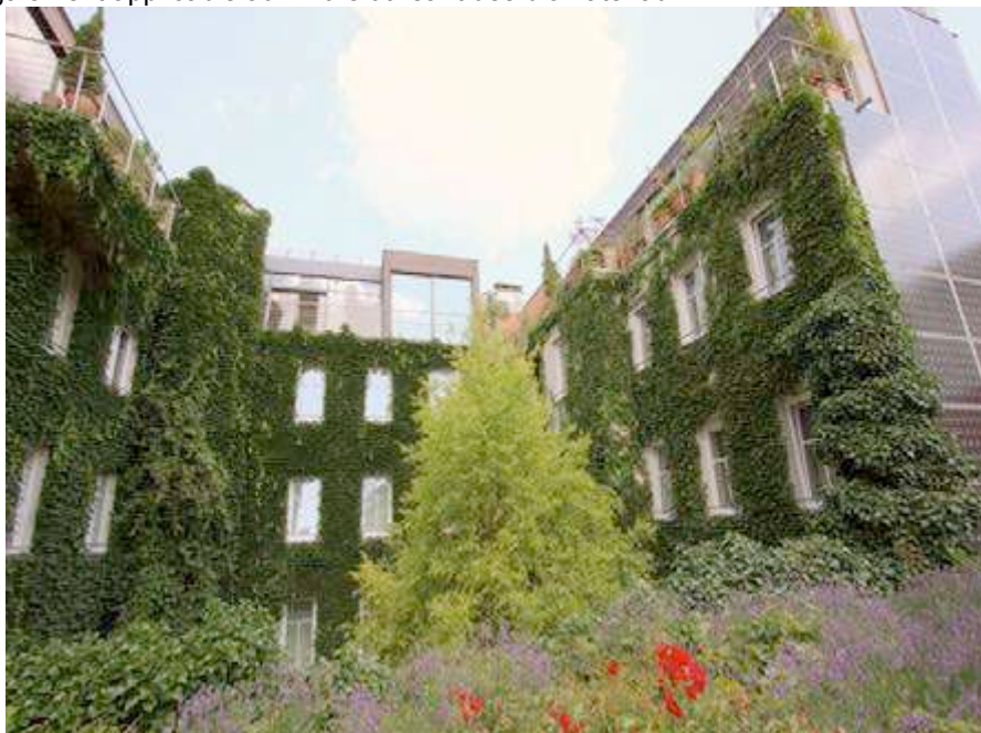
Association d'une façade verte et de panneaux photovoltaïques
