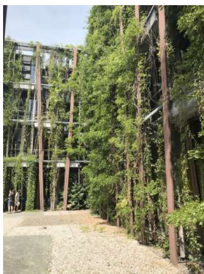
Berlin Adlershof – mélange de plantes grimpantes au sol et dans les supports de plantation © Green4Cities
