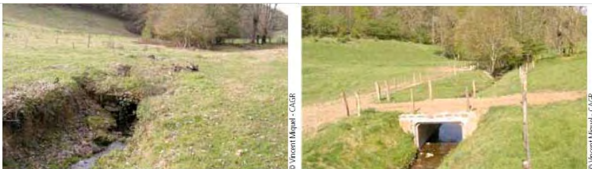
Avant la restauration (image de gauche) – 6 mois après la restauration (image de droite)
