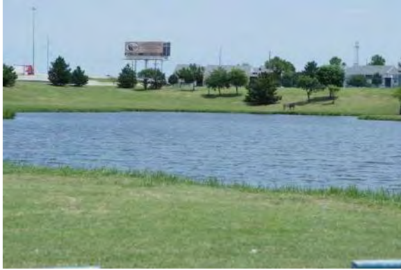
Bassin de rétention des eaux pluviales bordé de pelouses
