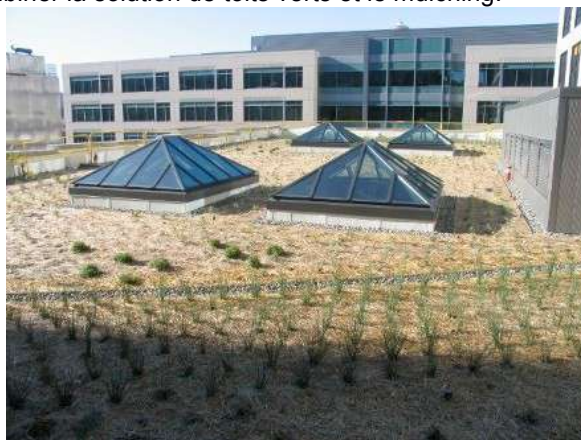
Mise en œuvre du mulching de foin sur un toit vert à Kirkland, WA, USA © Bark King
